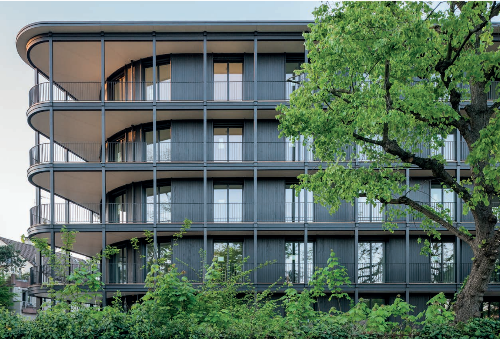
Wohnpark am Schaffhauser Rheinweg in Basel (Aussenschalung CH-Tanne keilgezinkt, astfrei, mit Farbbehandlung) © Philip Heckhausen
